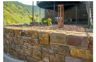
Bruchsteinmauerwerk
