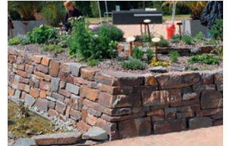
Trockenmauerwerk
